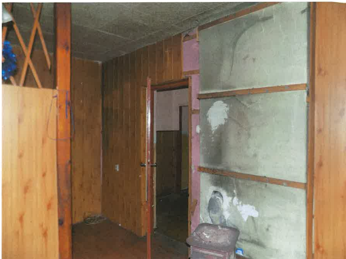
Mieszkanie przed remontem
