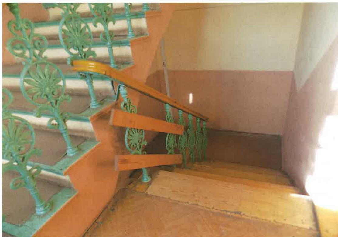
Klatka schodowa przed remontem
